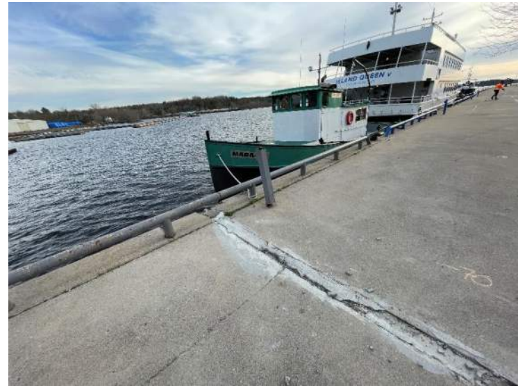
18- Structure C – Buried Conduit, Stn 0+069
